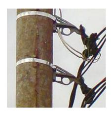
• При проведении работ на ВЛИ имеют место кустарные способы крепления и небрежное исполнение узлов крепления СИП. Такой монтаж трудно оправдать, поскольку он не приводит к экономии средств и затрачиваемого времени, а надёжность и внешний вид таких узлов существенно снижаются (фото 7).
