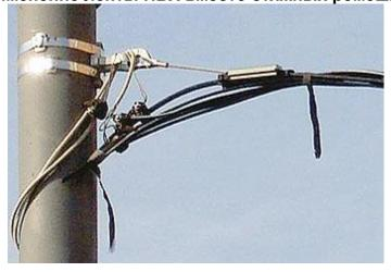
• Абонентские ответвительные провода (провода ввода) закрепляются в анкерных клиновых зажимах нескрученными (фото 3), что снижает надёжность крепления.
