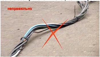
• Можно встретить провода, не скреплённые монтажными (стяжными) ремешками в тех местах, где они должны быть согласно технологическим картам. Отсутствие простейших и дешевых элементов портит внешний вид ВЛИ. Вместо монтажных ремешков иногда применяется изоляционная лента (фото 2) или алюминиевая проволока, что является очевидным нарушением.
